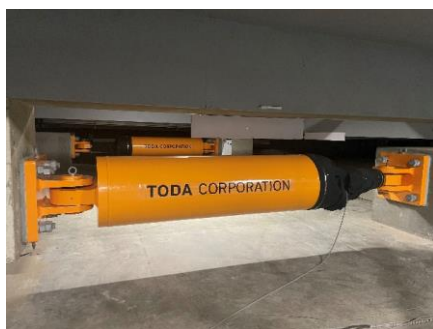
写真1 セミアクティブオイルダンパー
