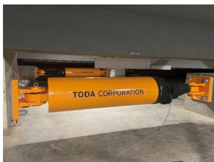
写真 1 セミアクティブオイルダンパー
