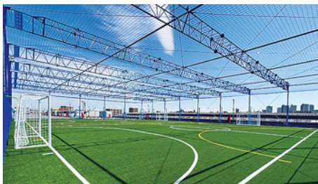
屋上の一角に人工芝のフットサルコート2面を整備した
